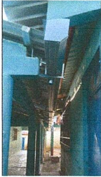
FOTO 1. SUSTITUCIÓN DE CANAL DE METAL
